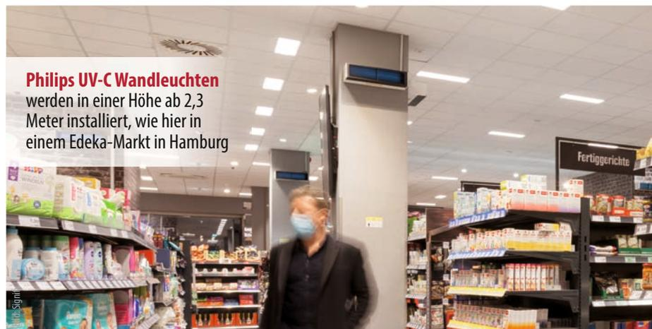
**Philips UV-C Wandleuchten** werden in einer Höhe ab 2,3 Meter installiert, wie hier in einem Edeka-Markt in Hamburg
